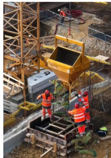
Benne couchée de 1250 L équipée d'un mécanisme TE
