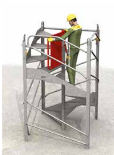
Pose ou dépose d'un garde-corps de fermeture
