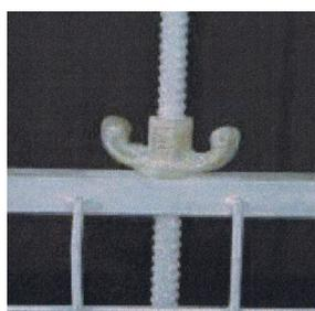
Une tige sur laquelle coulisse un écrou papillon. 2 oreilles assure le réglage de la hauteur sous le linteau.
