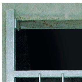
Le linteau est totalement dégagé pour faciliter les travaux de finition. La prise sous linteau est assurée par un plot de 5 mm d'épaisseur.
