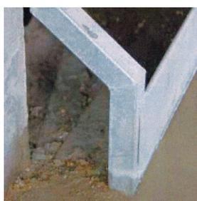
La plinthe est réglementaire : 15 cm. Sa partie supérieure est dégagée sur 25 cm pour permettre les finitions du seuil sans enlever la protection.
