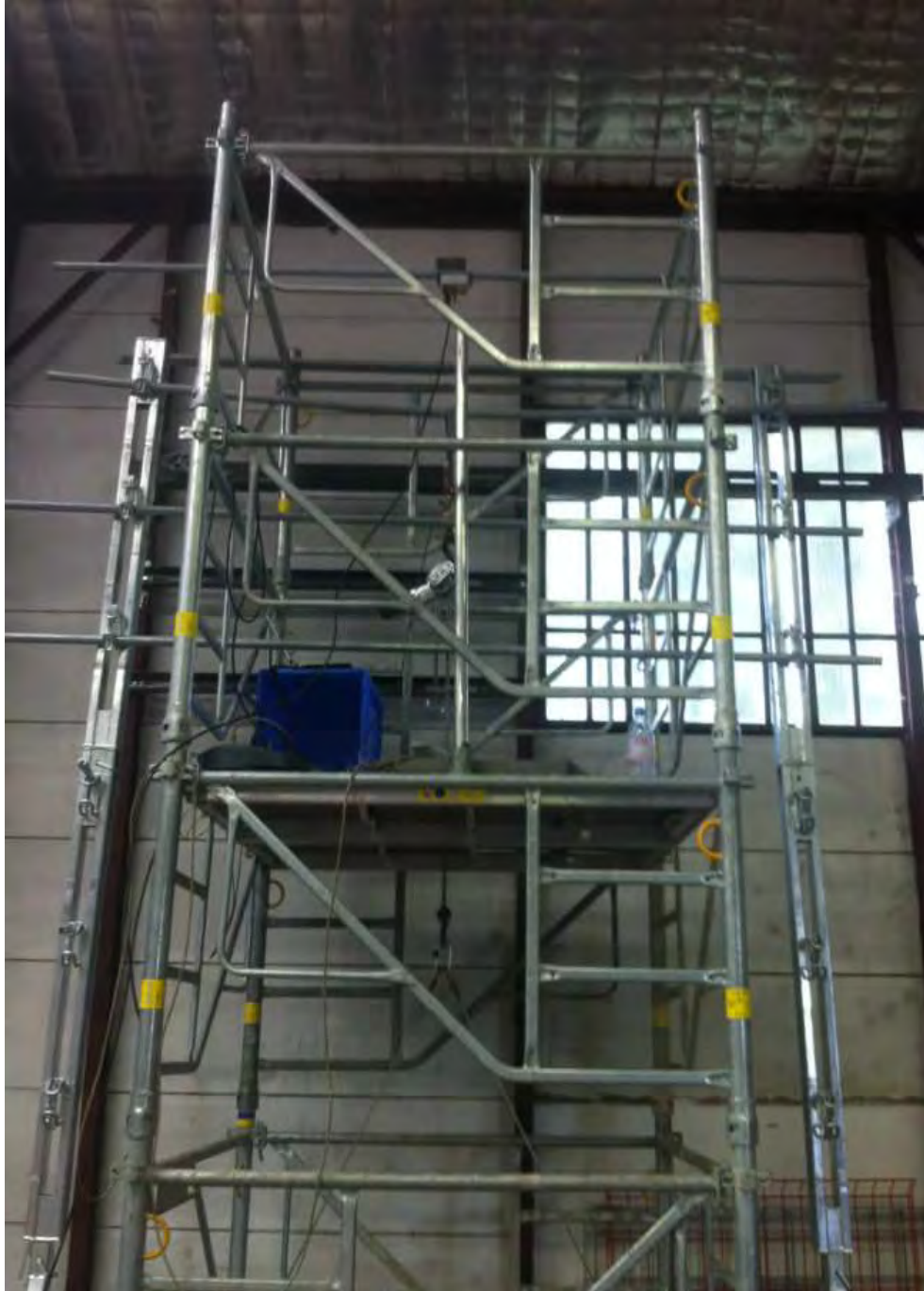
Structure pour la réalisation des essais
